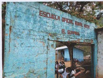
Foto2: Reparación y refuerzo a Ingreso principal de la escuela.
